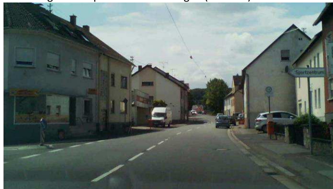
Abbildung 14: Hauptstraße in Eschringen (Bestand)
